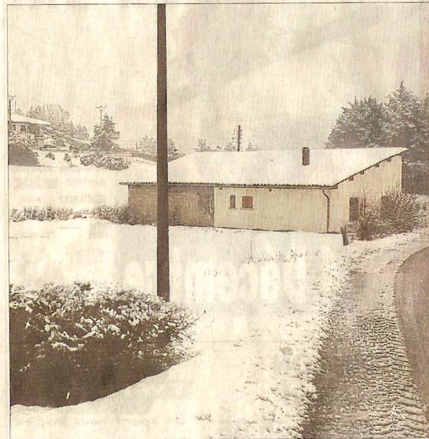
Toutes les lignes dans le quartier du Chapon vont être enfouies.
